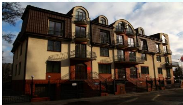
Budynek Zespołu Szkół
