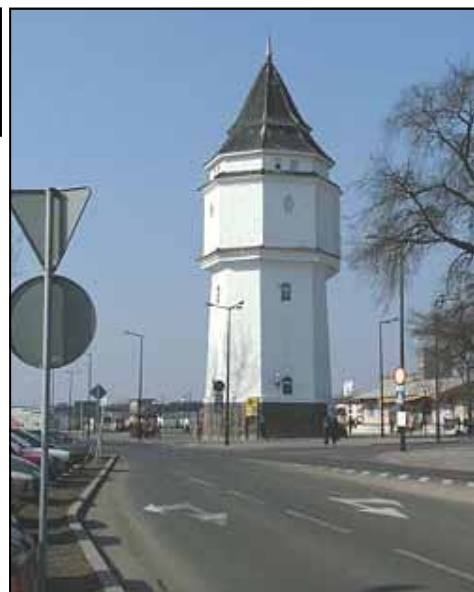
Nieczynna wieża ciśnień przy dworcu PKP w Koninie (obecnie galeria "Wieża Ciśnień")
